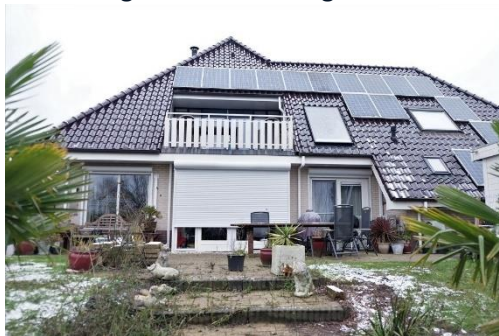
De achterkant van het huis, met de tuin op het zuiden. Voor de foto is het rolluik even zichtbaar gemaakt. Verder is een deel van de achttien zonnepanelen te zien.
